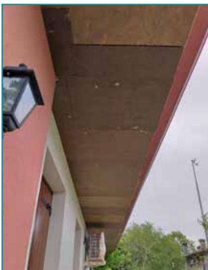
Nobilium®Thermalpanel come correzione ponte termico esterno
