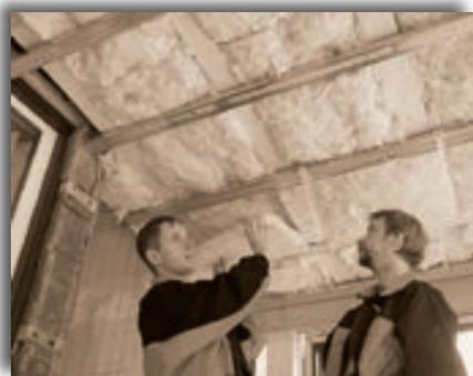
Stendere lo strato di isolante Starlon da 3mm oppure da 6mm oppure lana di roccia
