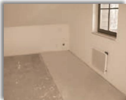
Stendere lo strato di isolante Starlon da 3mm oppure da 6mm
