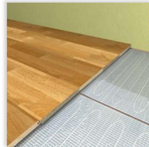
Ricoprire il tappeto direttamente con il parquet, facendo attenzione a non danneggiare i cavi scaldanti
