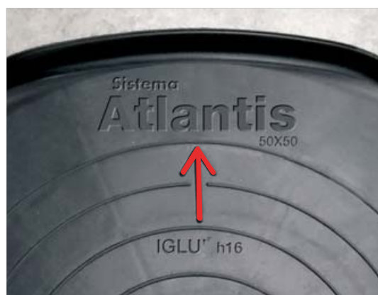
fig. 1 - Posa a secco del primo cassero, la freccia è rivolta verso il cordolo di fondazione
