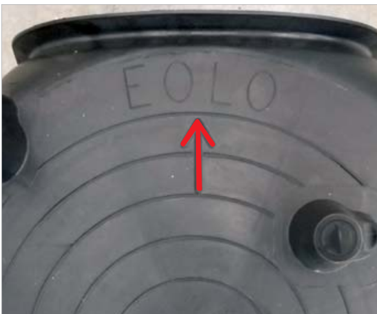
Fig. 1 - Posa a secco del primo cassero, la freccia è rivolta verso il cordolo di fondazione.
