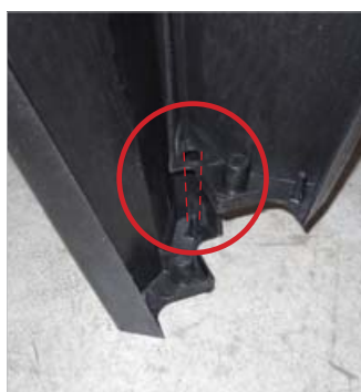
Particolare della fase di innesto del sistema maschio-femmina - Da notare la perfetta sigillatura del piede.
