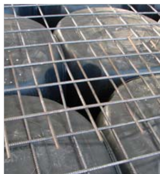
Particolari della sequenza completa di posa di Iglù ® , successiva armatura, getto e lisciatura.
