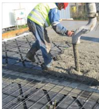
Particolari della sequenza completa di posa di Iglù ® , successiva armatura, getto e lisciatura.
