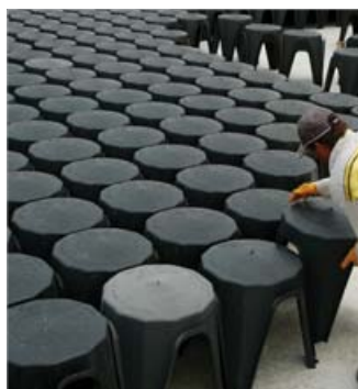
Particolari della sequenza completa di posa di Iglù ® , successiva armatura, getto e lisciatura.
