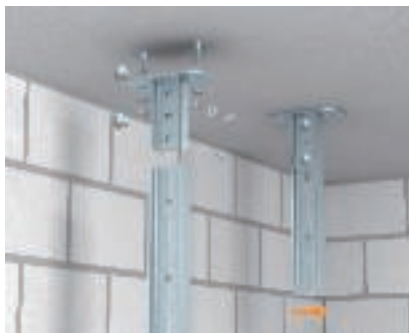
Montaggio di supporti a soffitto Fissaggio al soffitto in calcestruzzo del supporto a soffitto standard KI 8 per profilati di sospensione a I tramite tasselli.
