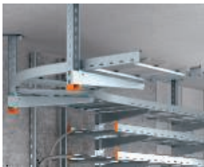
Montaggio ultimato Rappresentazione di un montaggio completo di passerelle.
