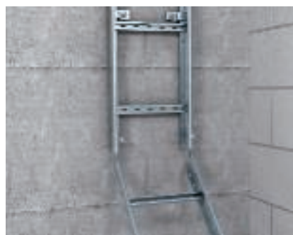
Giunzione snodata di passerelle Realizzazione di angolari per passerelle a spalliera di varia angolazione con giunti snodati tipo LGVG.
