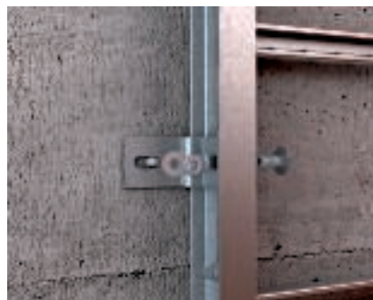
Fissaggio passerella a spalliera per industria Il fissaggio alla parete della passerella a spalliera per il settore industriale avviene con angolari di fissaggio tipo BW 80/55.
