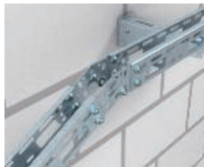
fissaggio longitudinale verticale Giunzione verticale ad angolo di passerelle AZ con due giunti tipo VF AZK.
