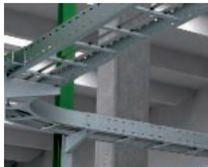
Utilizzo fissaggio su acciaio Montaggio di un sistema a grande portata fissato a supporti in acciaio.
