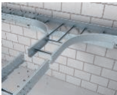
Montaggio della derivazione a T Derivazione a T in combinazione con passerelle a grande portata. La derivazione a T viene collegata alla passerella a grande portata con giunti esterni.
