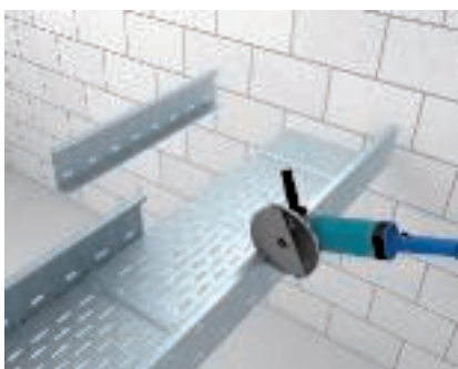
Realizzazione di una derivazione a T con curva Tagliare i due fianchi della passerella.
