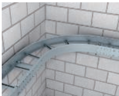
Montaggio della curva 90° Curva montata per passerella pesante. La curva viene collegata alla passerella pesante con giunti esterni.
