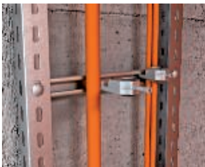
Fissaggio di conduttori con staffa reggicavo Fissaggio di una linea sul piolo con le staffe reggicavo.
