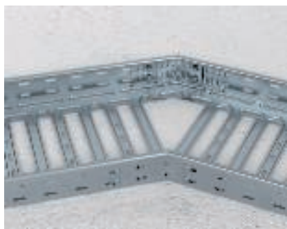
Realizzazione del cambio di direzione tagliando la canalina Unire le canaline tagliate e fissare dall'interno con due giunti angolari tipo RWVL.
