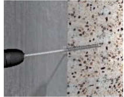
Pulizia con spazzola in acciaio Pulizia a macchina del foro con spazzola in acciaio. Il processo di pulizia con soffiaggio e spazzola deve essere eseguito due volte.
