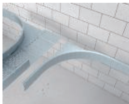
Realizzazione di una derivazione a T con curva Montaggio della seconda curva tipo WEAS 110.
