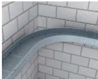
Montaggio della curva 90° Curva montata per passerelle portacavi pesante. La curva viene collegata alla passerella portacavi pesante con giunti e giunti esterni.
