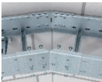
Giunzione Curva orizzontale per grandi portate. Giunzione Curva orizzontale di passerelle a grande portata con giunto angolare tipo WRWVK.
