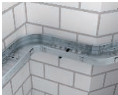
Montaggio della curva 90° Magic Installazione di curve in maniera semplice. Il lato della passerella con la molla si innesta dall'alto nella curva.
