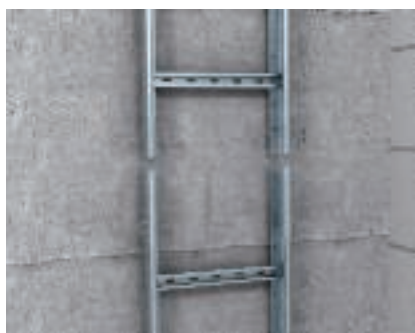
Giunzione lineare di passerelle a spalliera fissaggio di passerelle a scaletta tipo LG e SSL 60 con giunto tipo LVG.
