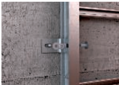
Montaggio con angolari di fissaggio avvitati
