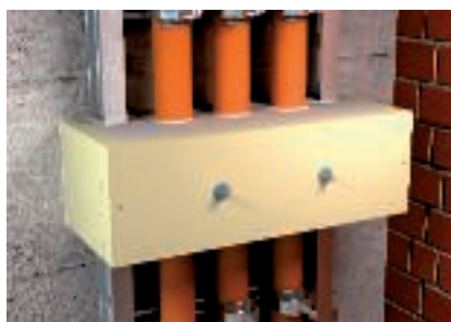
Protezione del fissacavo grazie alla compartimentazione locale garantita dal prodotto ZSE90
