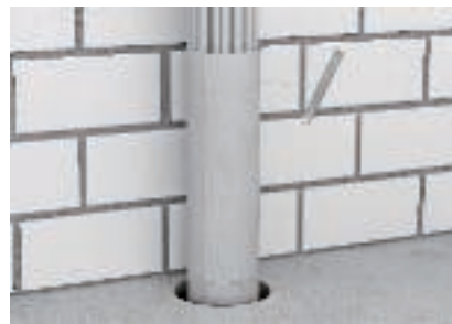
Fissaggio della fasciatura tramite filo di avvolgimento
