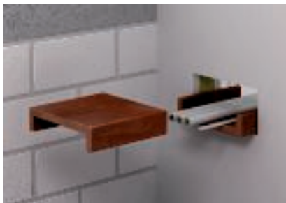
Installazione del telaio con cavi già installati
