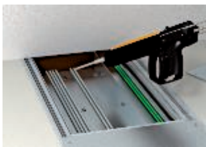
Applicazione della schiuma antincendio direttamente sotto la parete
