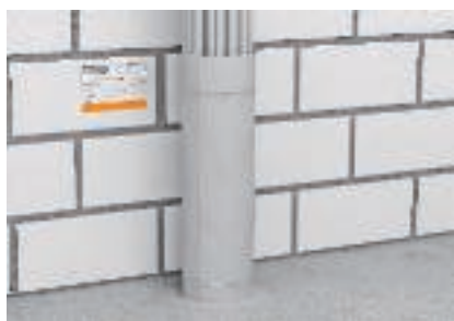
Chiusura dell'apertura del rivestimento restante con malta e montaggio con etichetta di contrassegno
