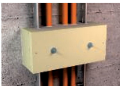
Compartimentazione del fissacavo utilizzando l'articolo ZSE90
