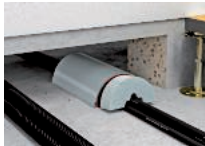
Adattare i tappi in espanso alle linee
