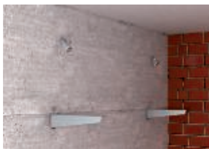
Montaggio della mensola e dei componenti di collegamento alla parete
