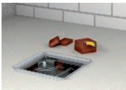
Taglio di strisce sottili per i gruppi di canali.
