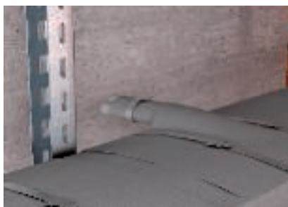
Uscita cavo con fasciatura
