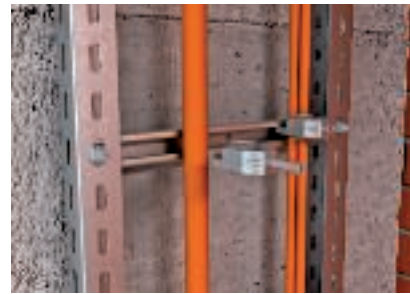
Installazione dei cavi con staffe reggicavo, possibile anche per più cavi
