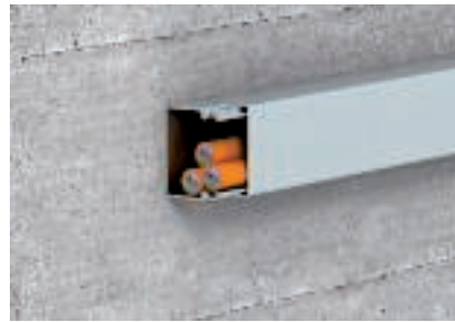
Posa pulita di cavi dati e di segnalazione incendio nel canale di tipo 20030
