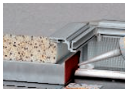
Sigillare le fughe residue tra cavi e blocchi con stucco FBA-SP.
