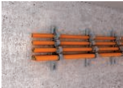
Montaggio orizzontale dei cavi con staffe reggicavo sulla parete
