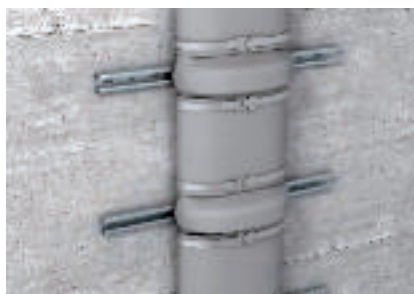
Fissaggio dell'isolamento con espansori metallici con l'installazione di un profilato
