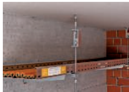
Fissaggio a soffitto delle aste filettate con staffa tagliafiamma
