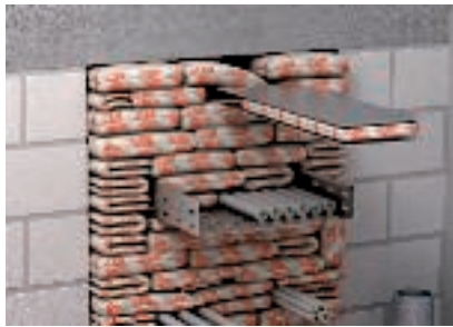
Lamiera come supporto per la posa dell'ultimo strato di sacchetti
