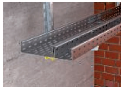
Montaggio di 2 canaline insieme su una mensola ammasso
