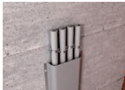
Fissaggio dell'isolamento con profilati metallici con l'installazione di una fascetta singola
