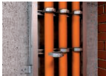
Installazione cavi con staffe reggicavo sui pioli della passerella a scaletta
