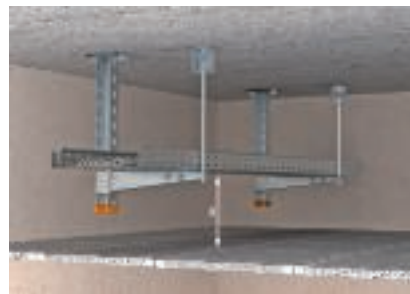
Distanza minima necessaria dal soffitto antincendio
