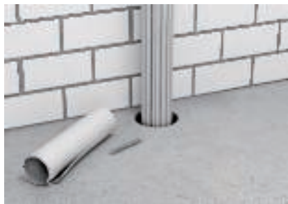
Preparazione dell'isolamento per cavi
