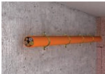
Montaggio orizzontale dei cavi sulla parete
