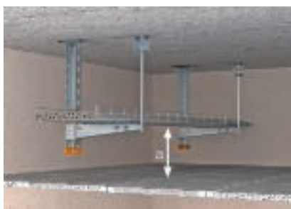
Distanza minima necessaria dal soffitto antincendio
