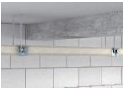
Installazione sospesa su elementi di collegamento
