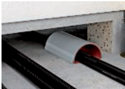
Posizionamento del semiguscio nell'apertura da sigillare
