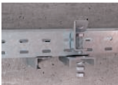
Fissaggio del componente di collegamento inclinato
