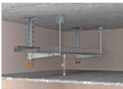
Distanza minima necessaria dal soffitto antincendio
