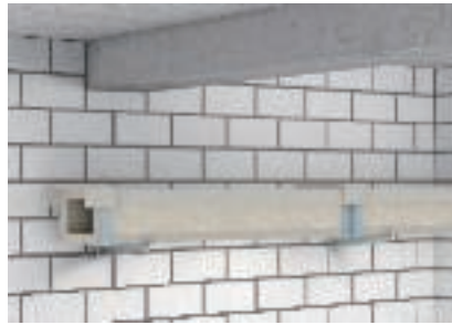
Installazione a parete come canale classe I (DIN 412-11)
