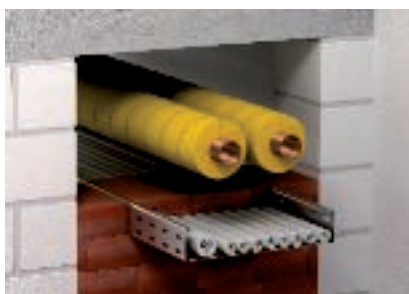
Tubi non incombustibili con isolamento
