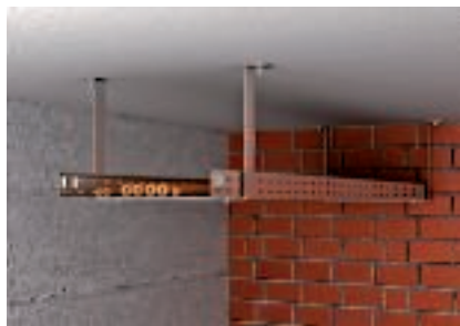
Installazione a soffitto singola con staffa di sospensione
