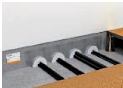
Semiguscio installato con malta PYROMIX®
