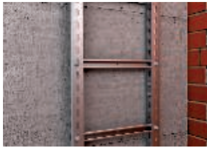
Montaggio diretto della passerella a spalliera su parete massiccia
