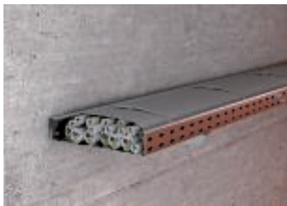
Inguainatura completa dei cavi in una passerella installata a parete
