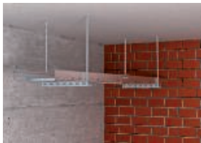
Sospensione a soffitto singola
