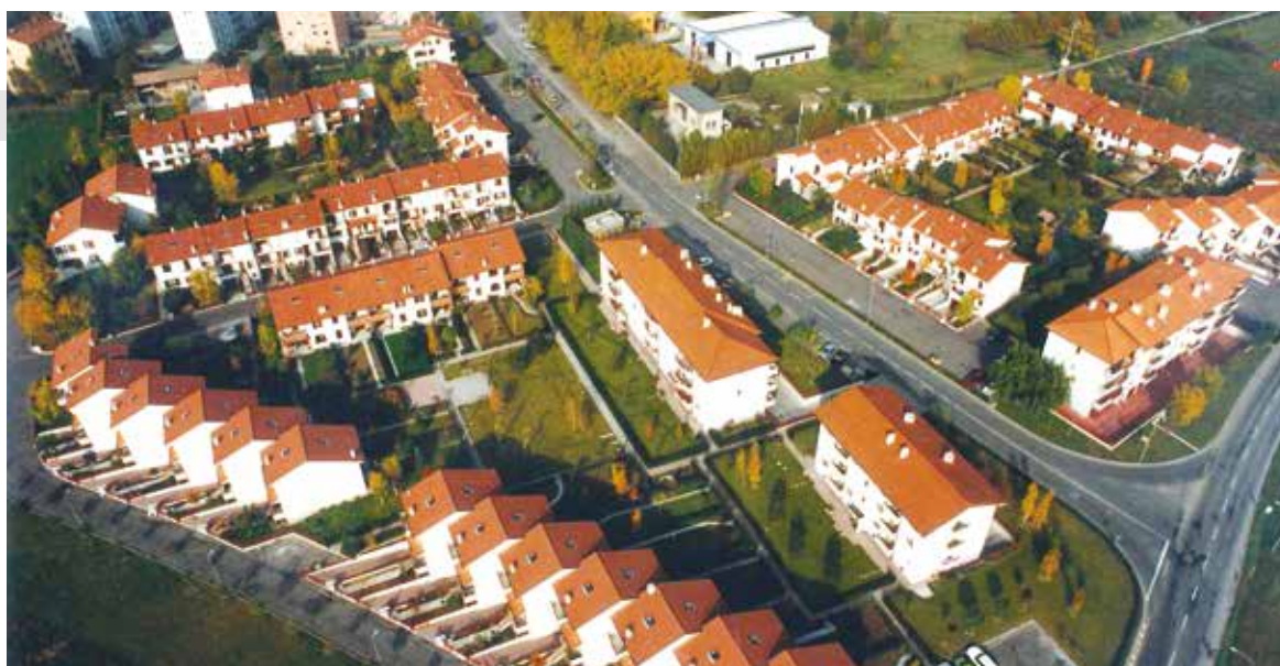
Intervento di 110 abitazioni a FIDENZA (PR) - 1985
