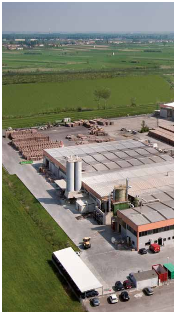
Stabilimento produttivo Isotex
