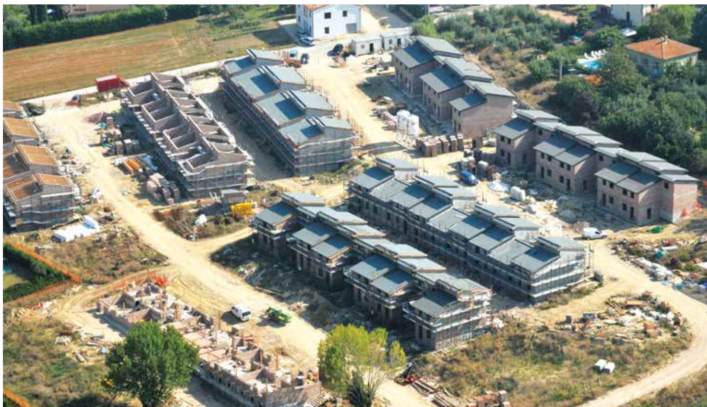
Intervento di 46 alloggi a SANT'ENEA - 2009
