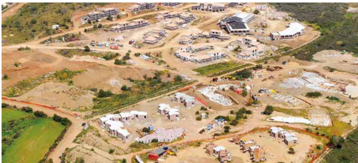
Intervento alberghiero costituito da 300 camere a BUDONI (NU) - 2005
