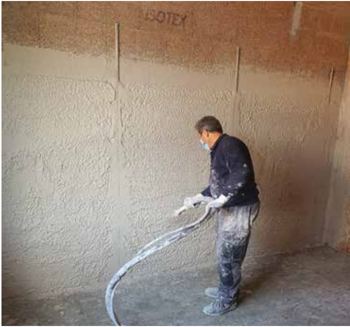
Applicazione di intonaci premiscelati e tradizionali
