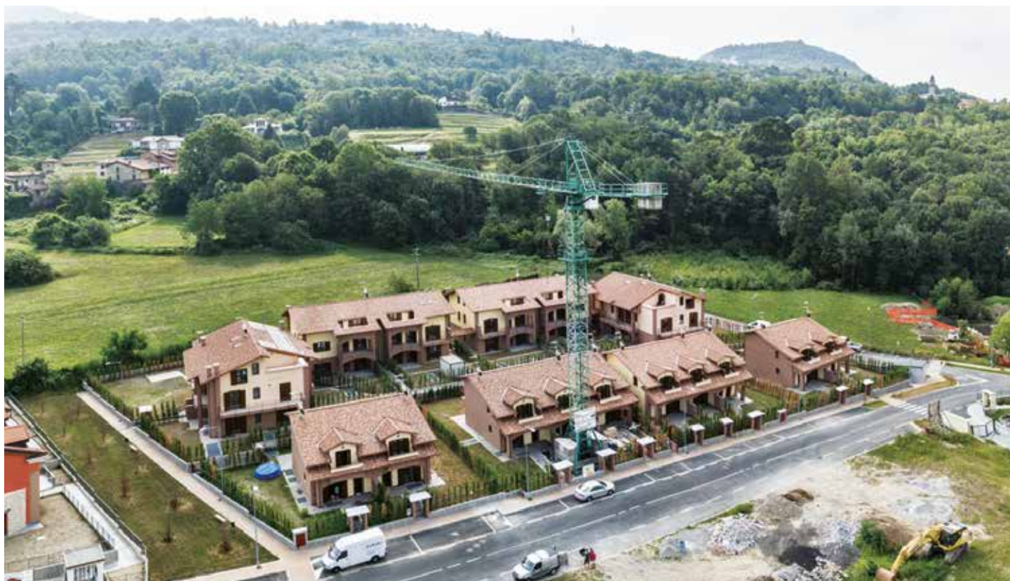
Complesso residenziale a DOLZAGO (LC) - 2009
