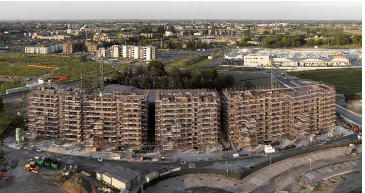
Intervento Social Housing di 400 alloggi a PARMA - 2011-2012
