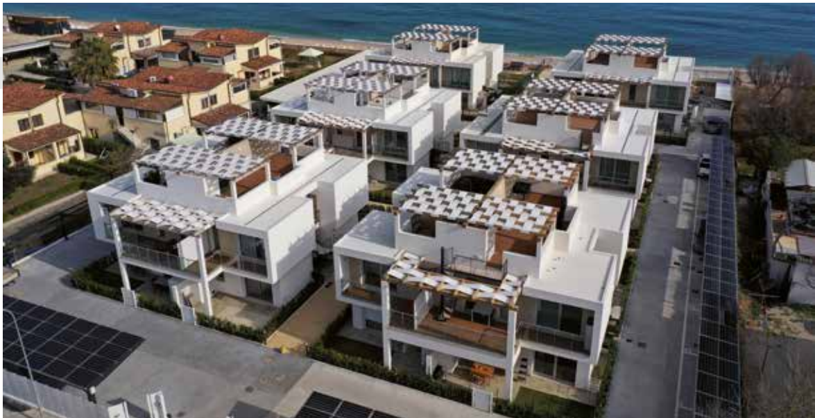
Intervento di 14 alloggi a PORTO RECANATI (MC) - 2019
