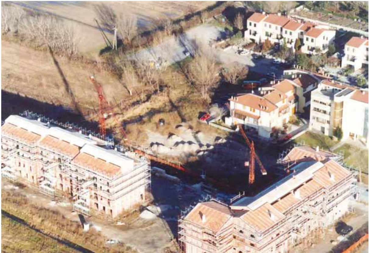
Costruzioni a più piani a PORTO GARIBALDI (FE) - 1999
