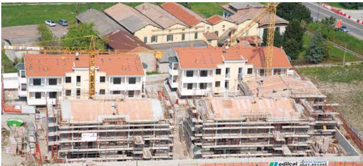
Intervento di 40 alloggi a PONTETARO NOCETO (PR) - 2008-2009
