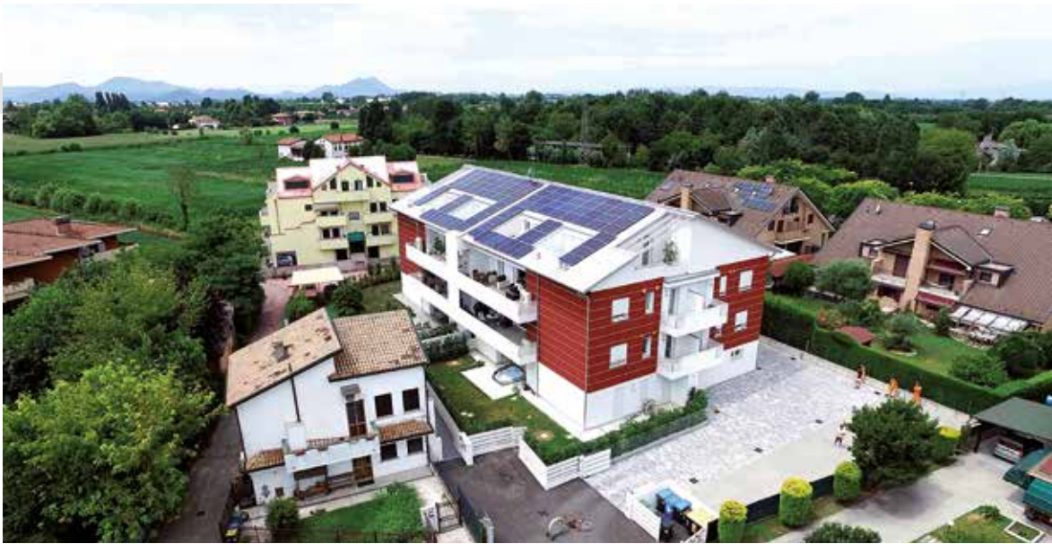
Edificio residenziale di 15 alloggi a MONTA' (PD) - 2017
