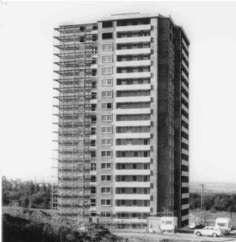
Edificio 17 piani a BAD WALDSEE - 1974
