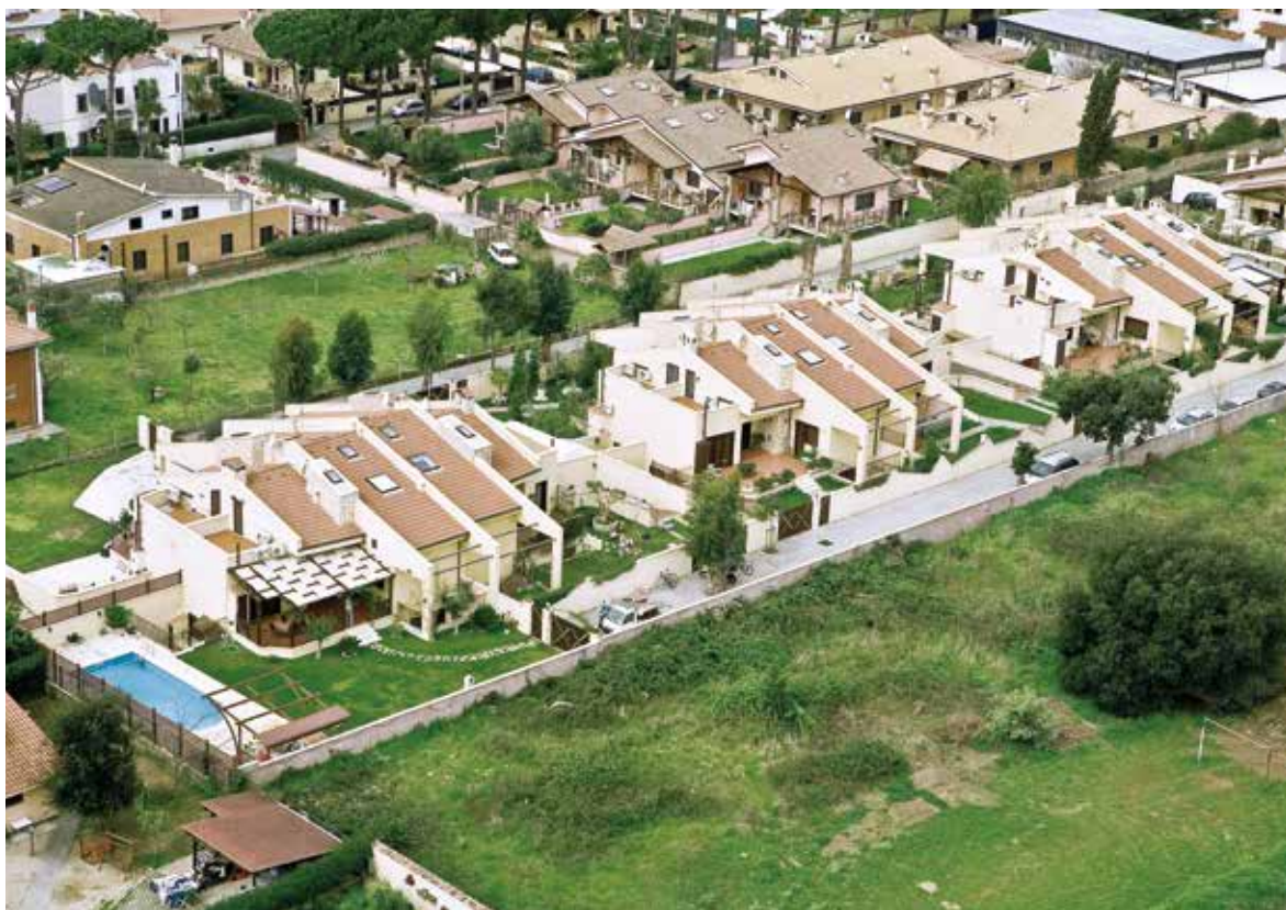
Intervento di 12 ville a schiera a CASTEL PORZANO (RM) - 2004-2005
