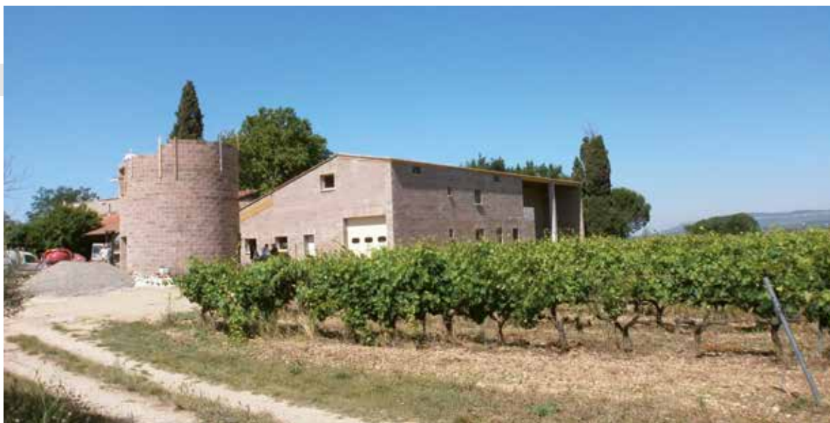
Cantina vinicola realizzata a DOMAINE PINCHINAT - (FRANCIA) - 2013
