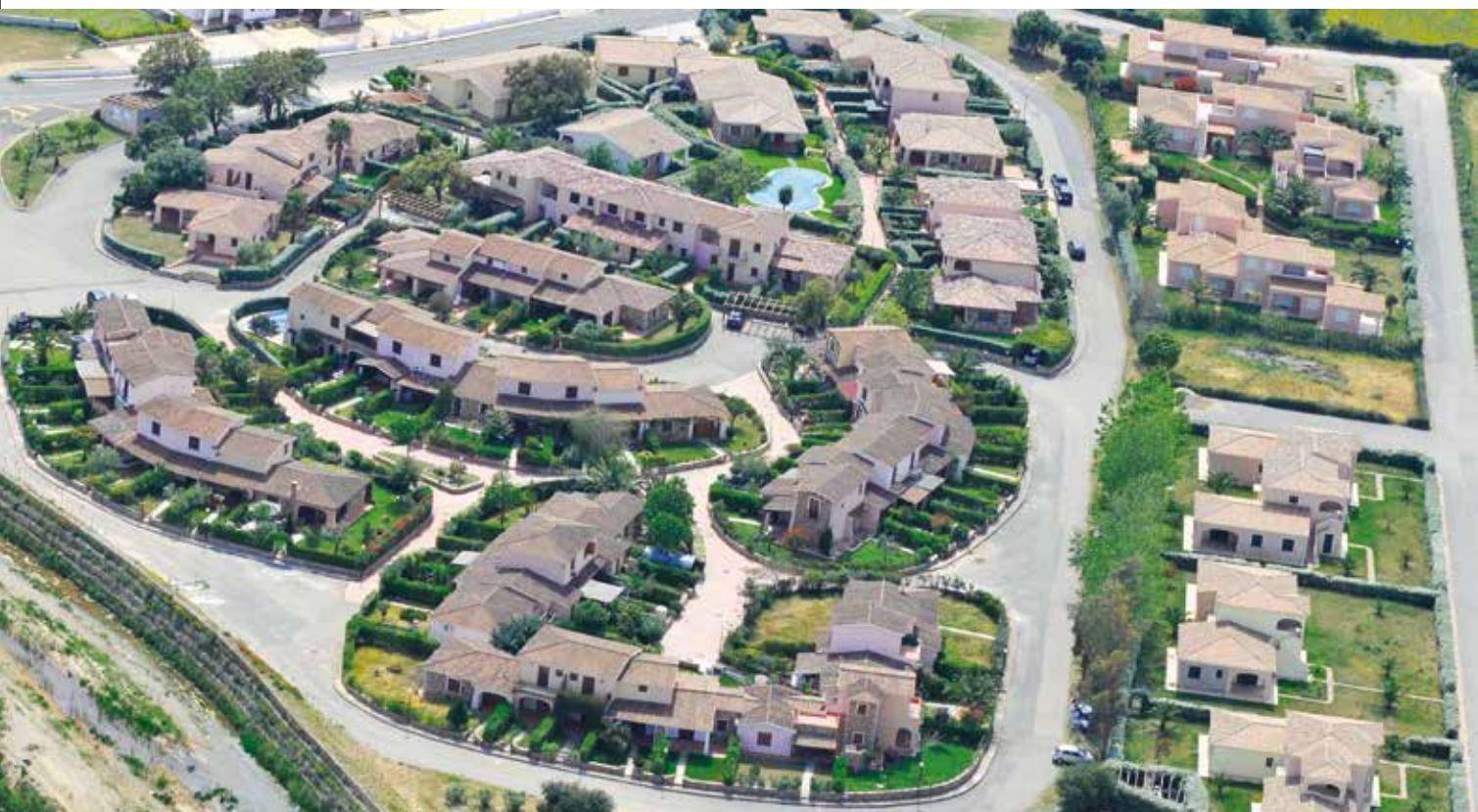
Complesso residenziale di 96 abitazioni a SAN TEODORO (NU) - 2001
