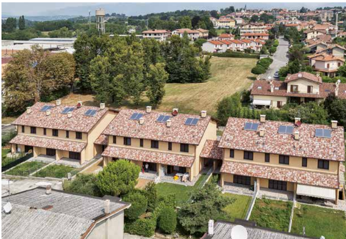
Intervento 9 alloggi BESANA BRIANZA (MB) - 2010
