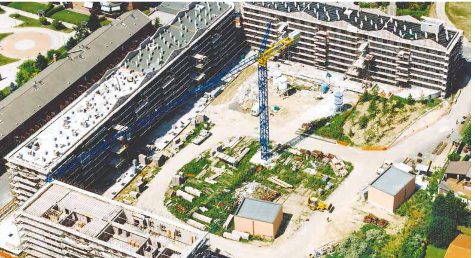
Intervento di 96 alloggi ad ALESSANDRIA - 2001
