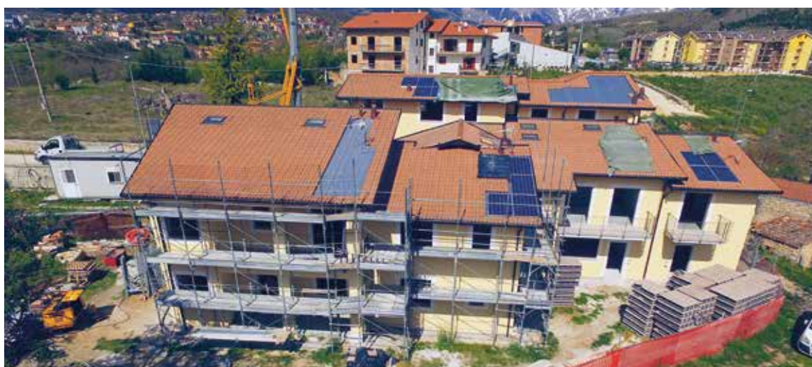
Intervento di 16 alloggi a SANT'ELIA (AQ) - 2017
