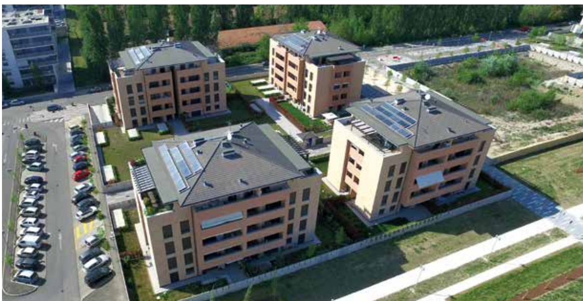
Intervento di 70 alloggi a PARMA - 2016
