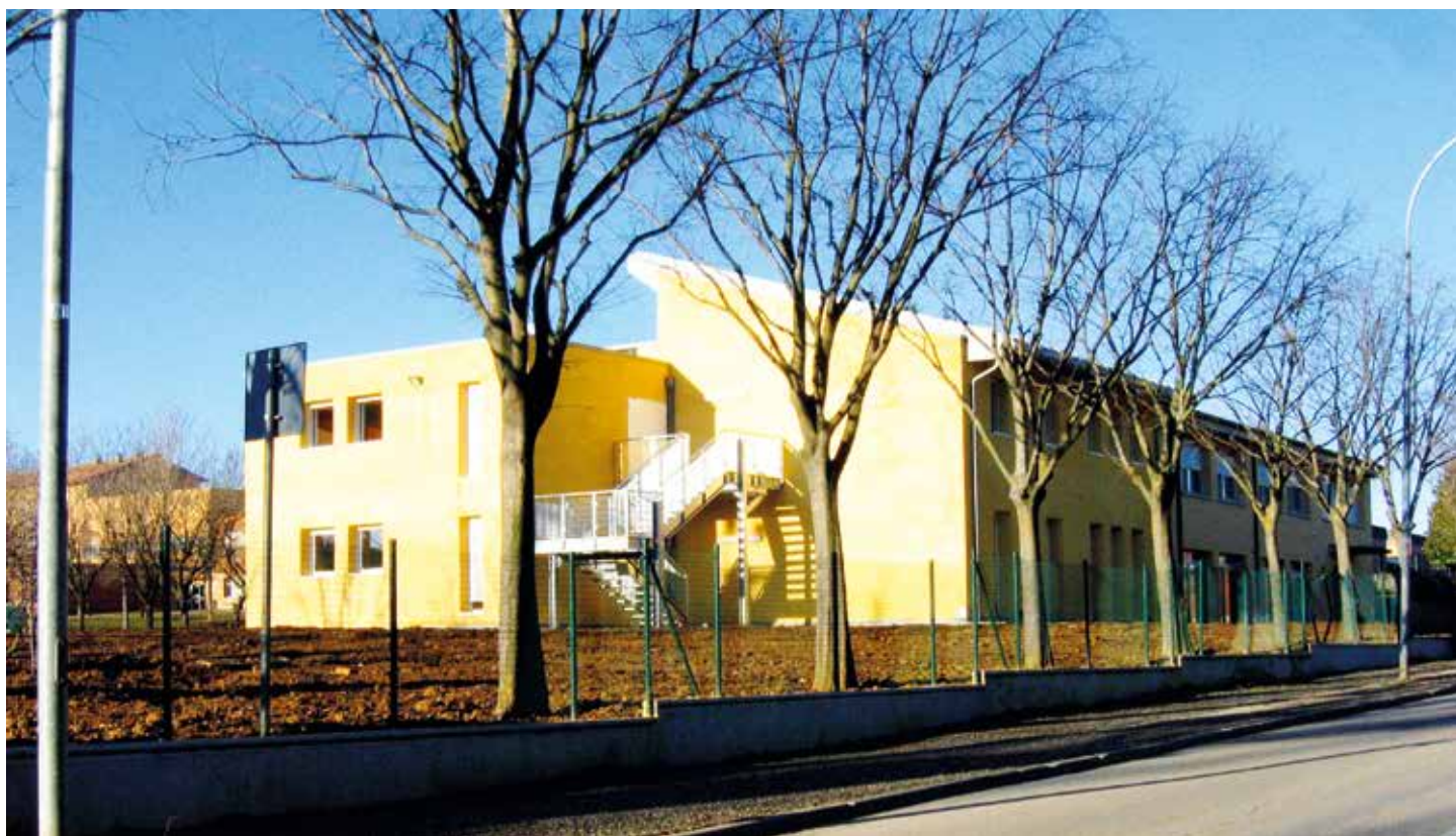
Edificio scolastico a DOZZA (BO) - 2008
