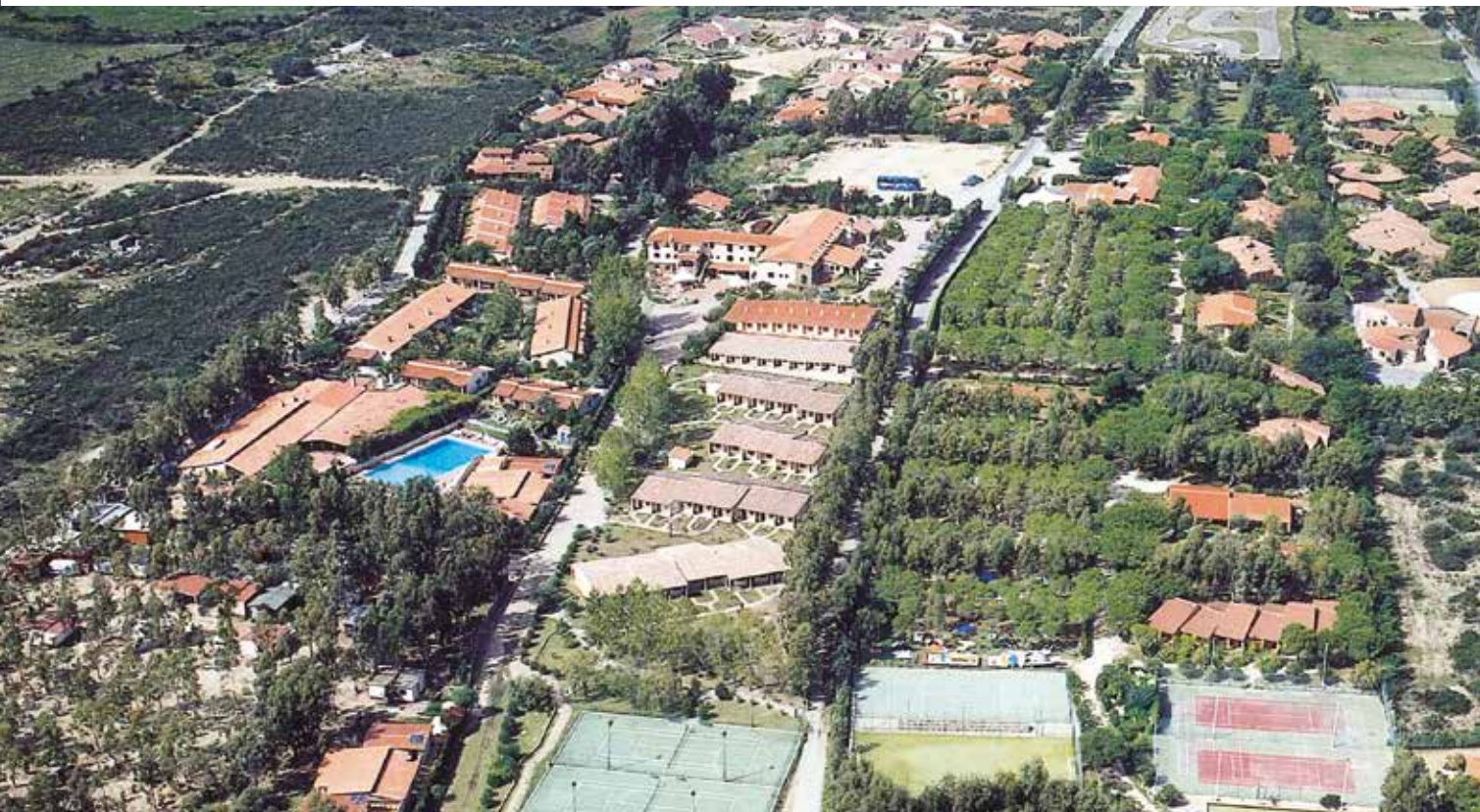
Intervento a SAN TEODORO (NU) - 2000
