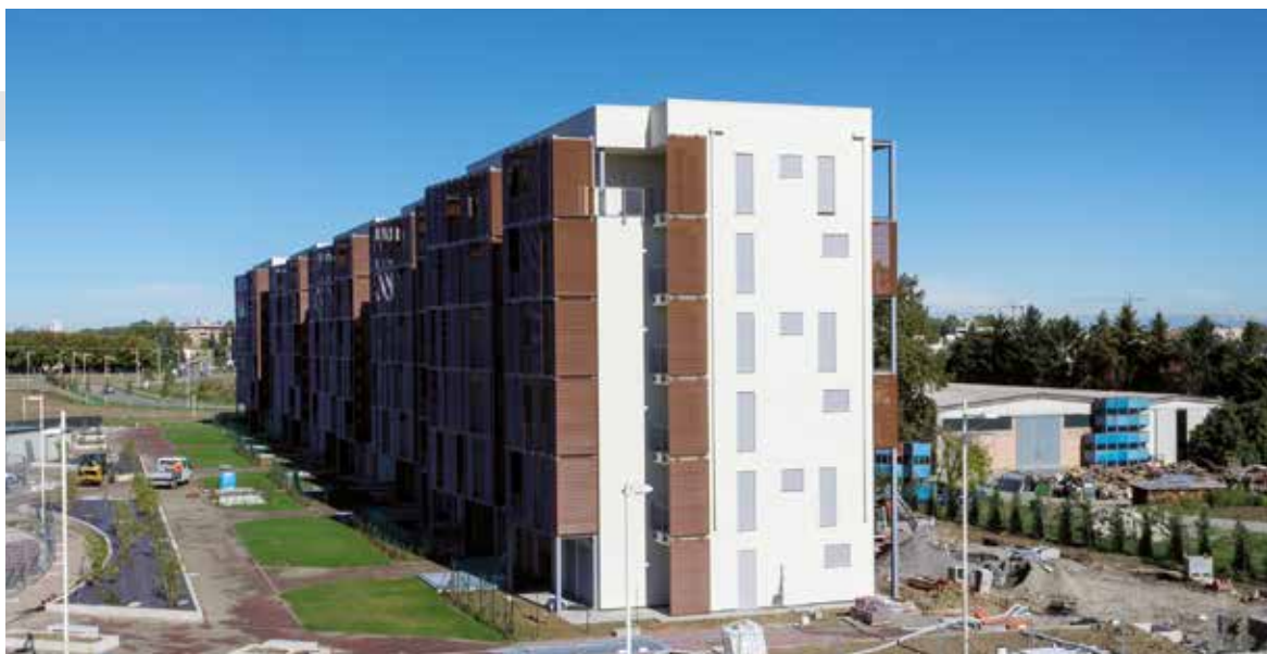
Intervento Social Housing realizzato a PARMA - 2012
