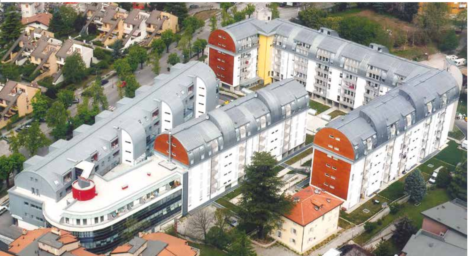
Intervento di 160 alloggi a ROVERETO (TN) - 2004
