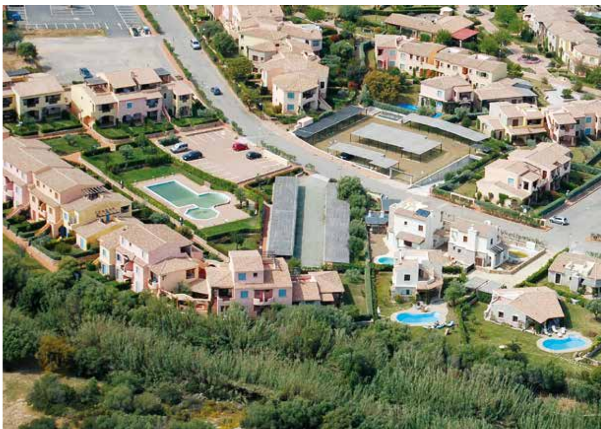
Intervento residenziale di 56 alloggi a PORTO SAN PAOLO (OT) - 2005-2007
