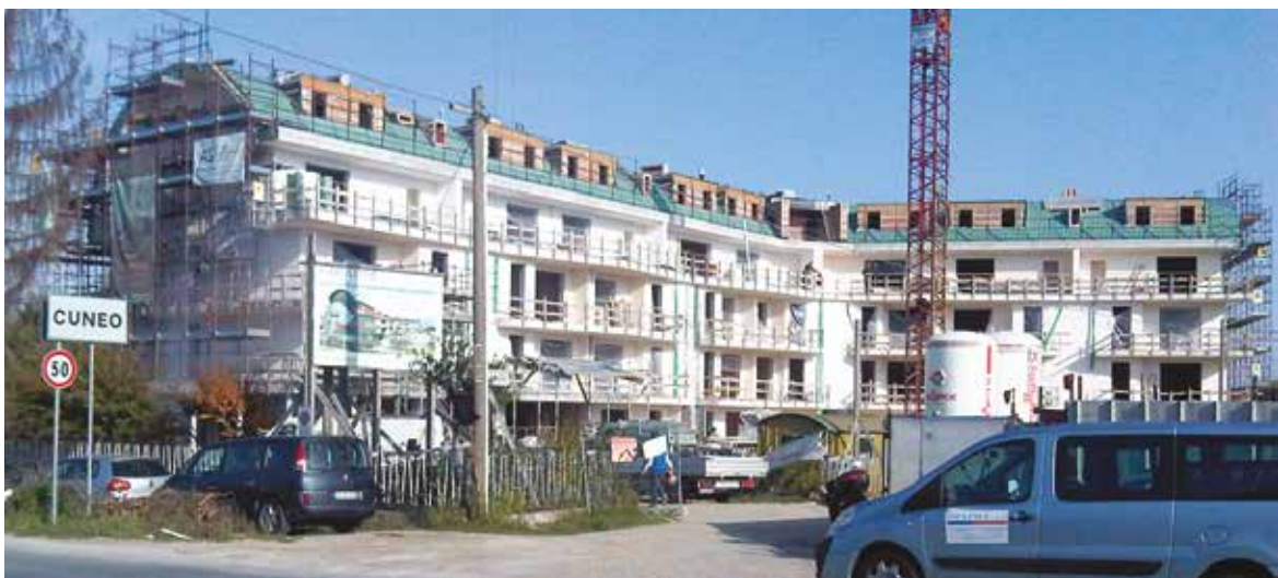
Intervento 36 alloggi a CUNEO - 2010
