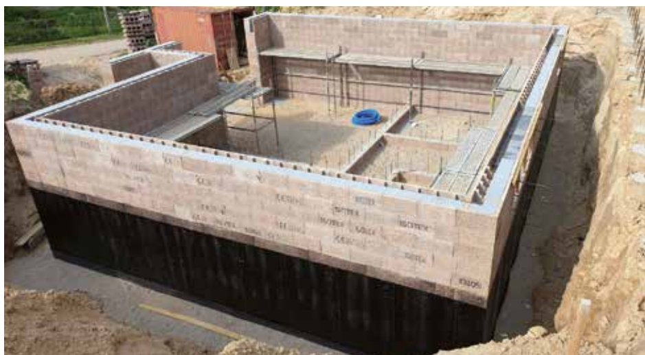
Villa unifamiliare realizzata in LITUANIA- 2019
