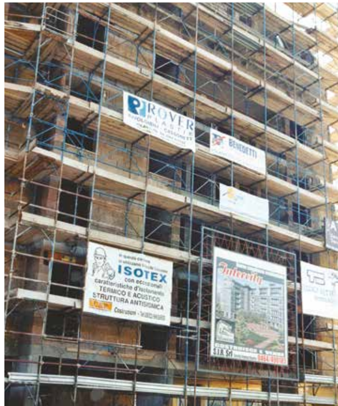
Intervento di 160 alloggi a ROVERETO (TN) - 2001
