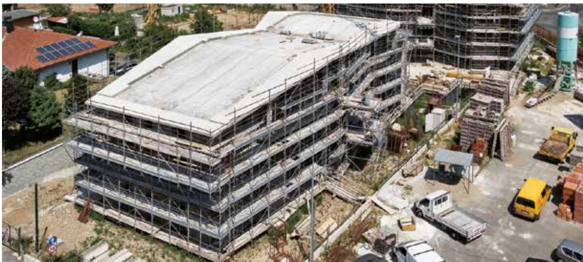
Intervento di 2 palazzine a CASOREZZO (MI) - 2010
