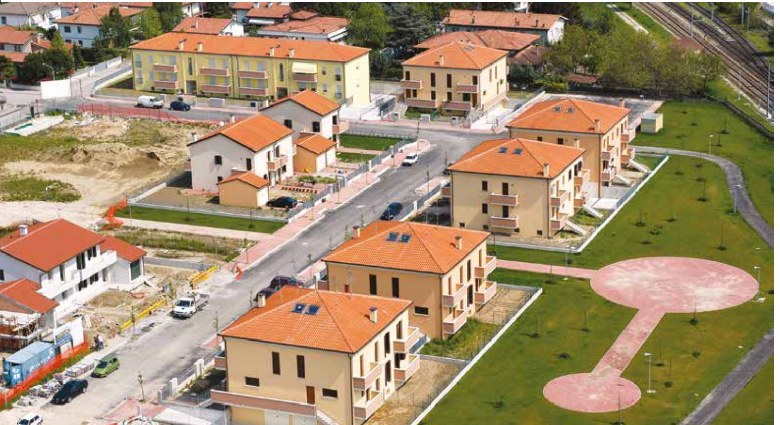
Intervento di 70 alloggi a PADOVA - 2005
