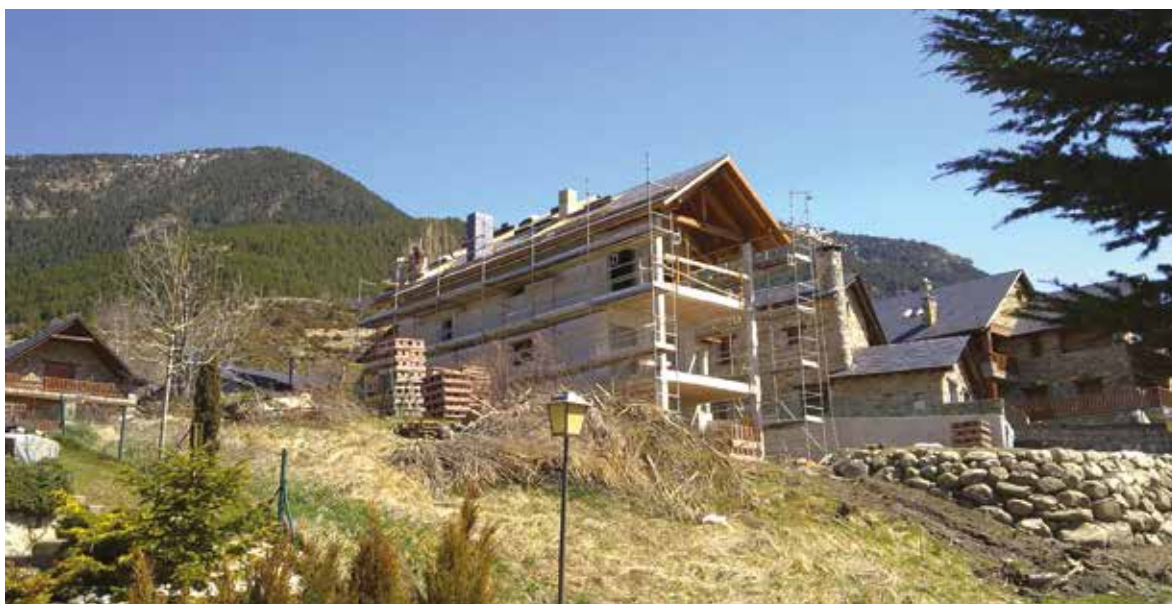
Edificio plurifamiliare realizzato a CERIER HUESCA - (SPAGNA) - 2011
