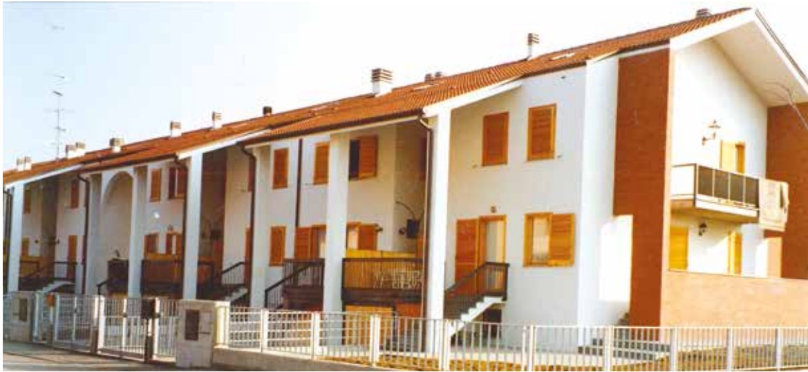
Intervento di ville a schiera a PARMA - 1987
