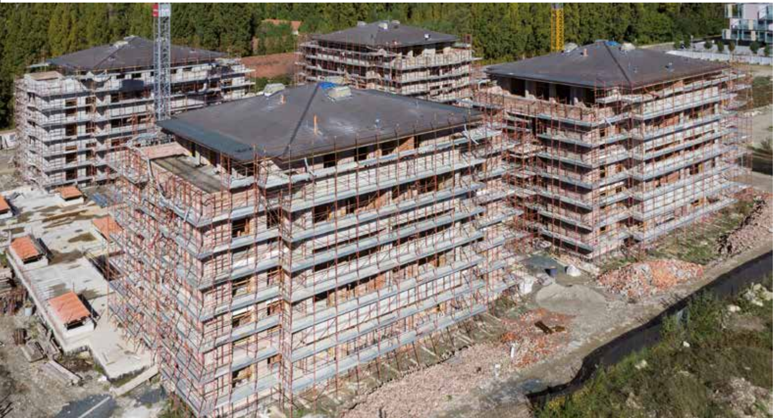
Intervento di 70 alloggi a PARMA - 2013-2015
