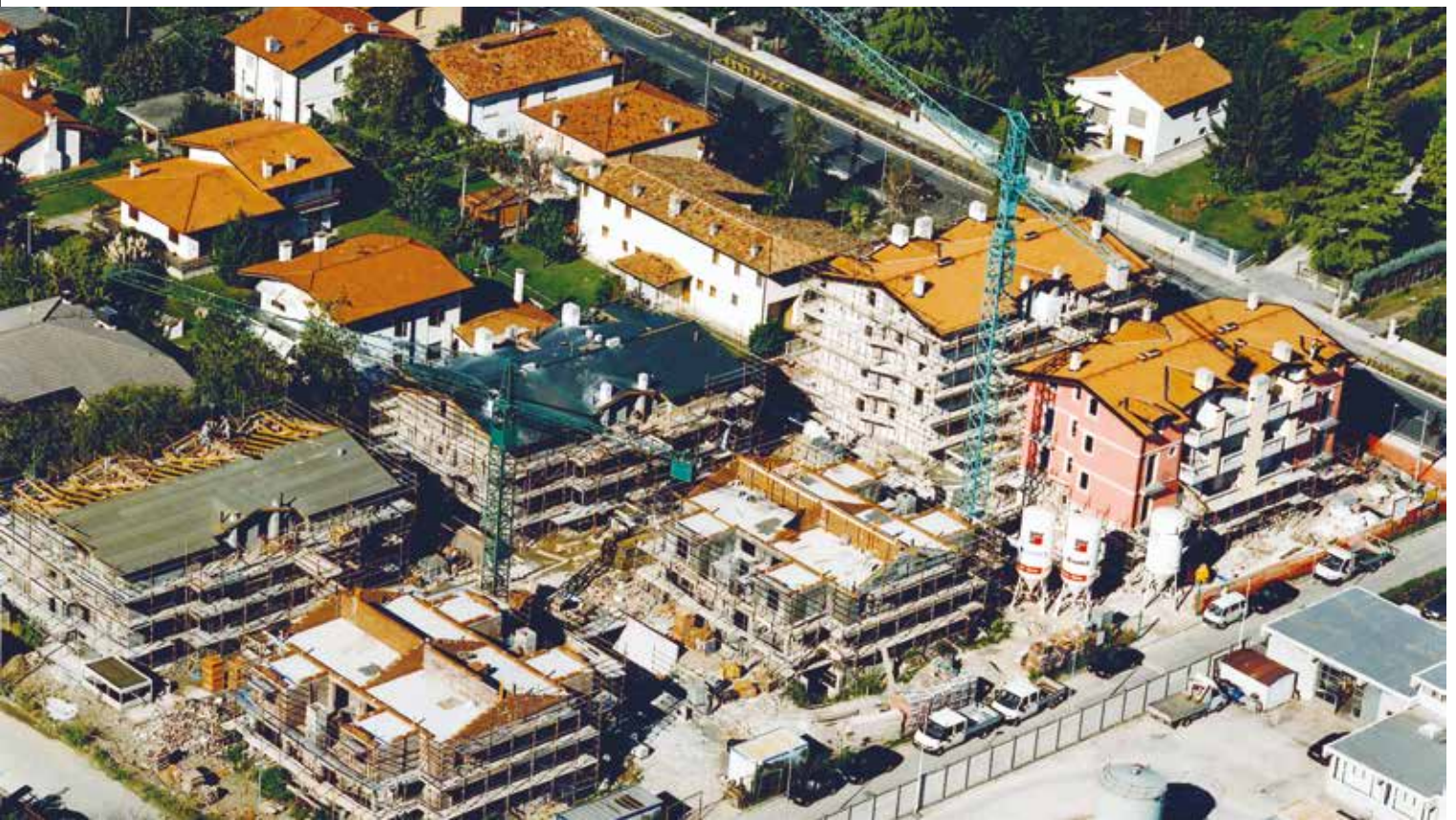
Quartiere residenziale di 52 alloggi a CERVIGNANO (UD) - 2002
