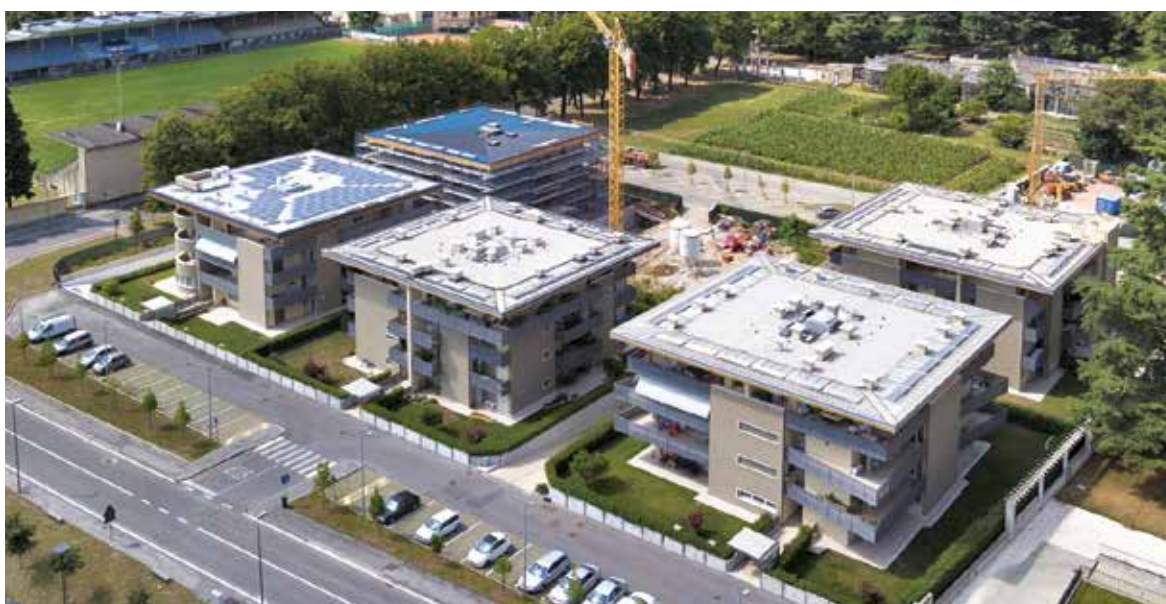
Intervento di 5 palazzine a VALDAGNO (VI) - 2011
