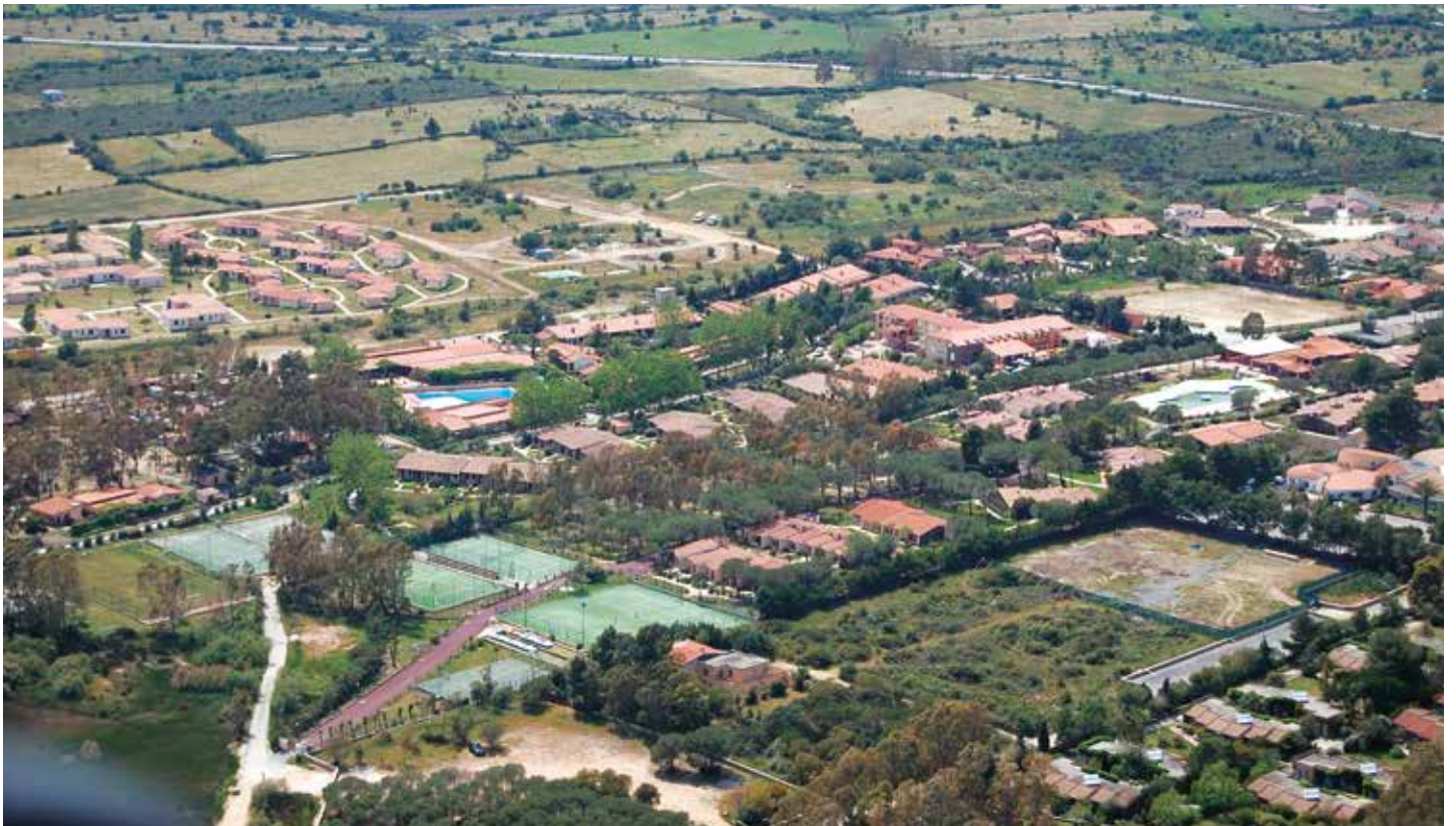
Intervento alberghiero di 120 camere a BUDONI (NU) - 2004
