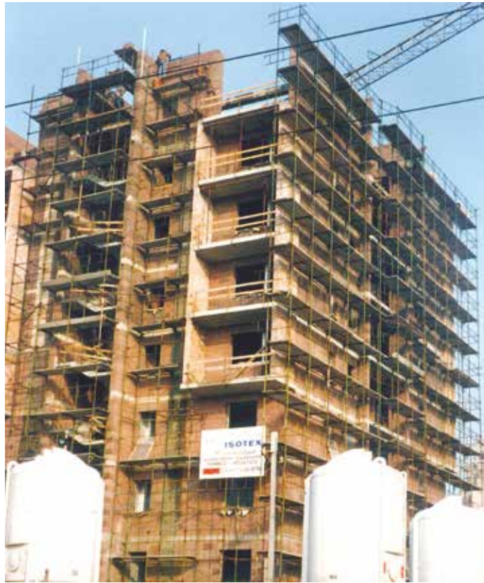
Edificio 8 piani con 28 alloggi a PARMA - 1991
