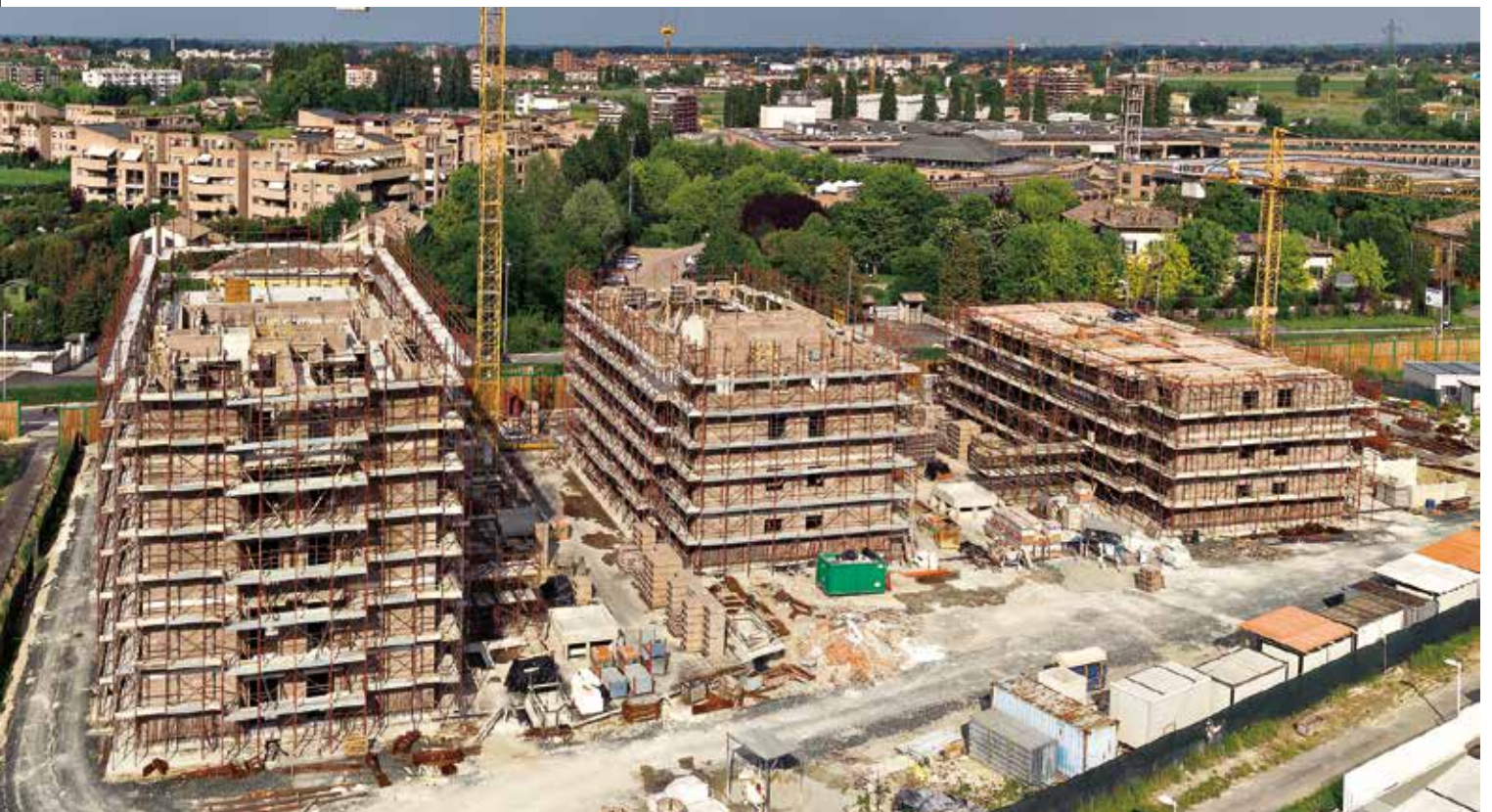
Intervento Social Housing di 400 alloggi a PARMA - 2011-2012
