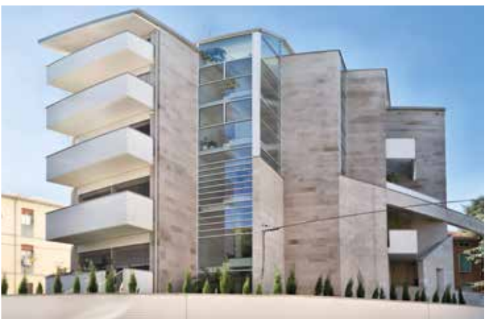
Rivestimento in marmo
