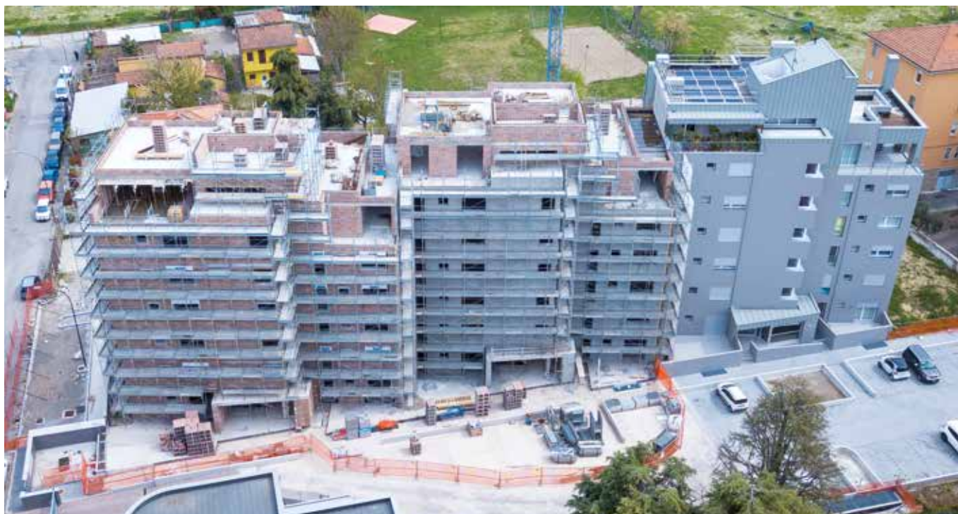
Varie fasi di lavorazione per rivestimento in Gres porcellanato: 1 • Blocchi grezzi - 2 • Rasatura con intonaco - 3 • Applicazione Gres porcellanato
