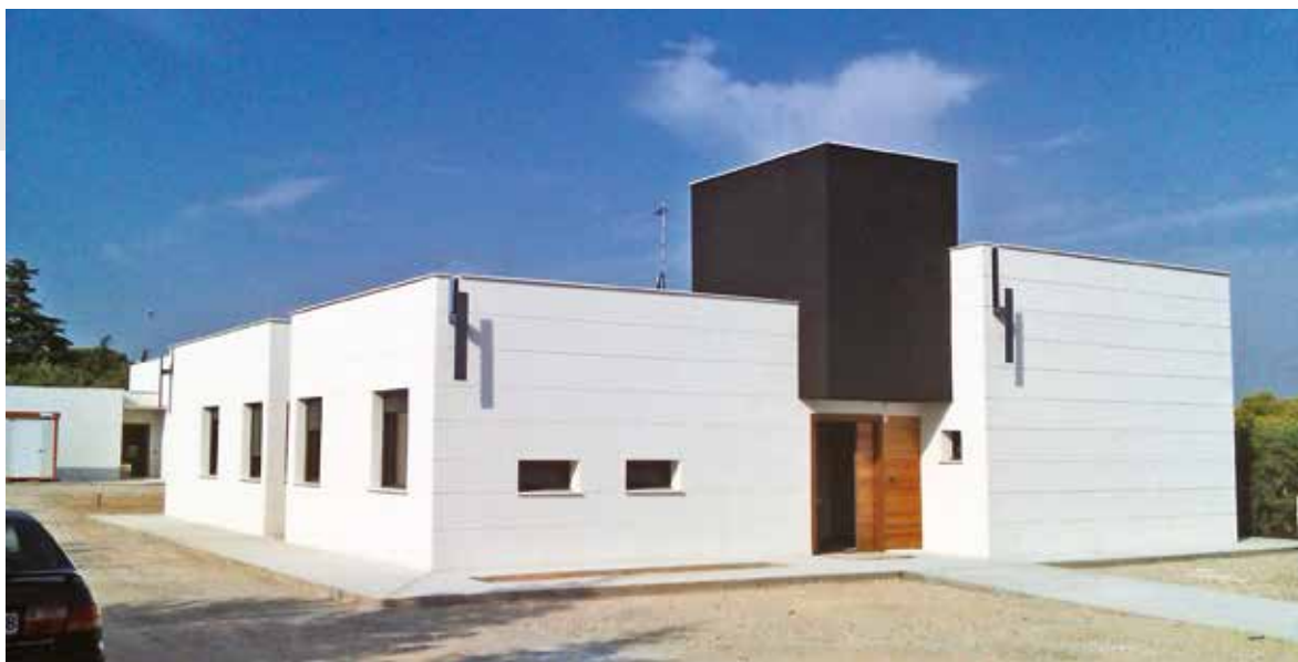
Bifamiliare realizzata a SARAGOZA - (SPAGNA) - 2009
