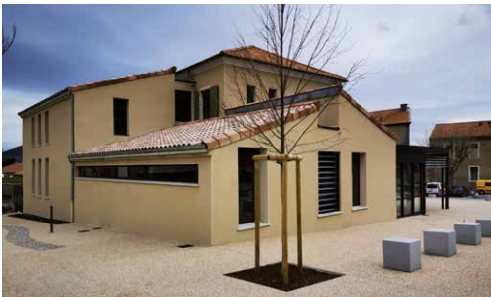
Centro medico realizzato a CRUAS - (FRANCIA) - 2019
