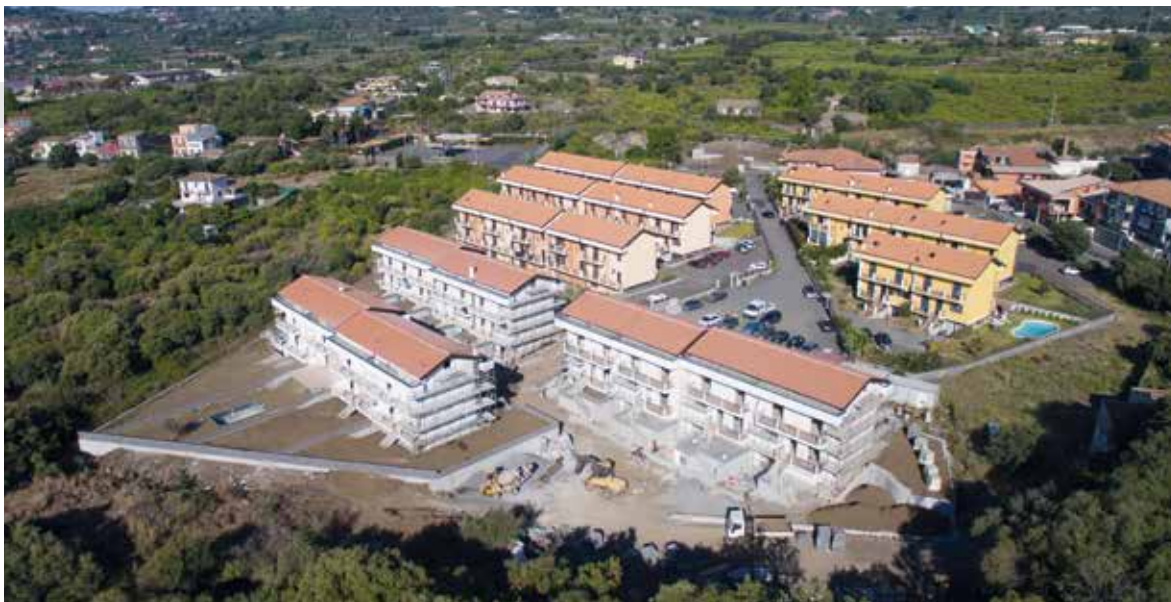
Quartiere residenziale ad ACIREALE (CT) - 2017
