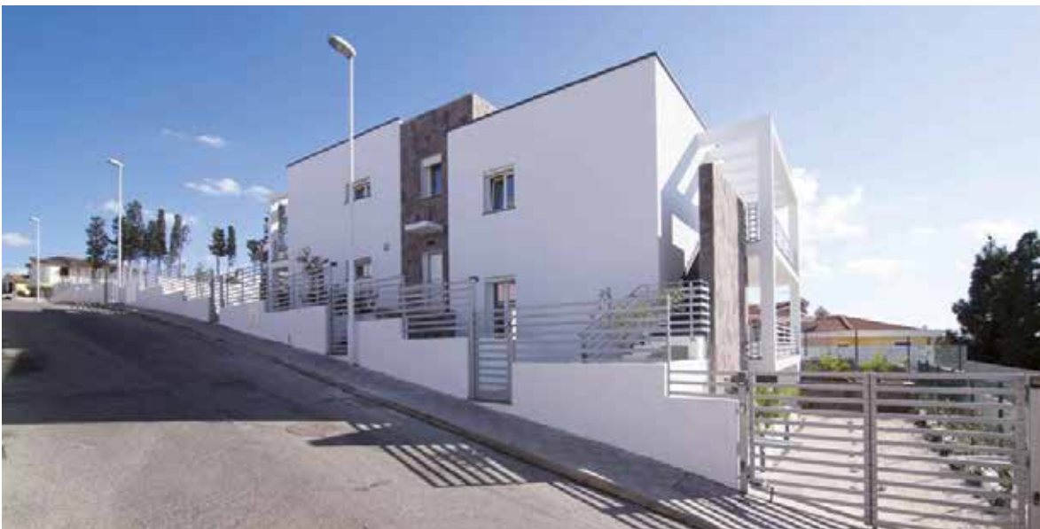
Complesso residenziale 5 alloggi a BARACCAMANNA (CA) - 2017
