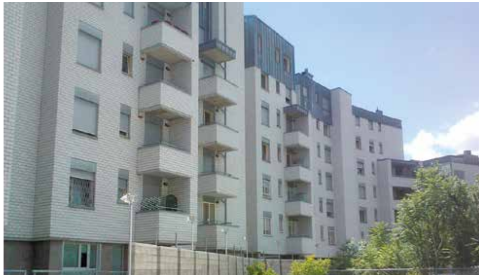
Intervento palazzina 6 piani a BOLOGNA - 2008
