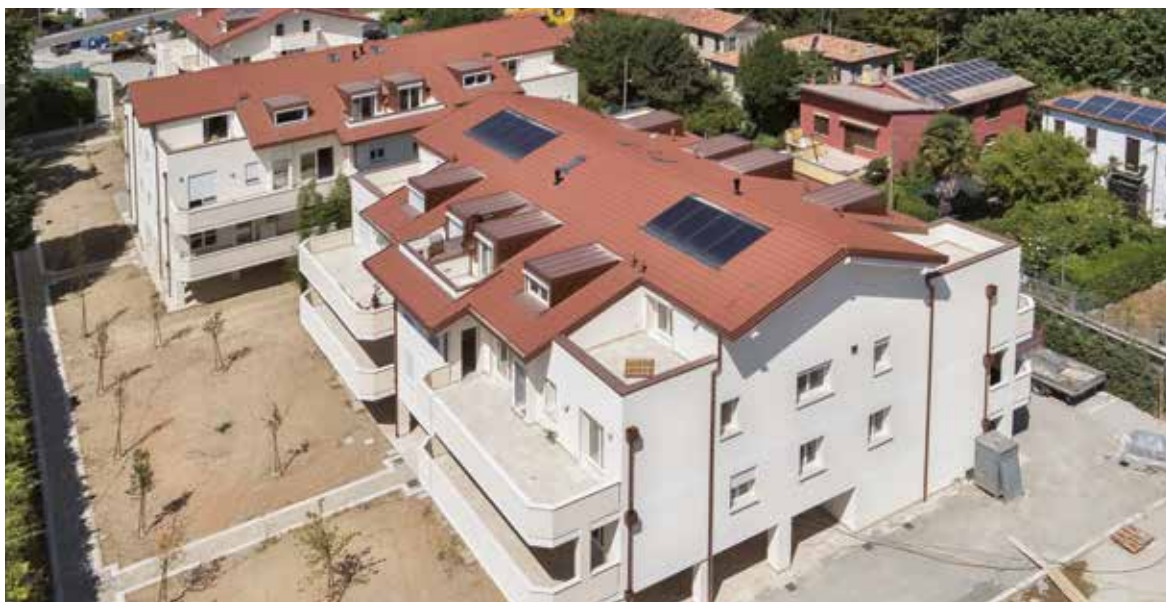
Intervento di 2 palazzine a PADOVA - 2011
