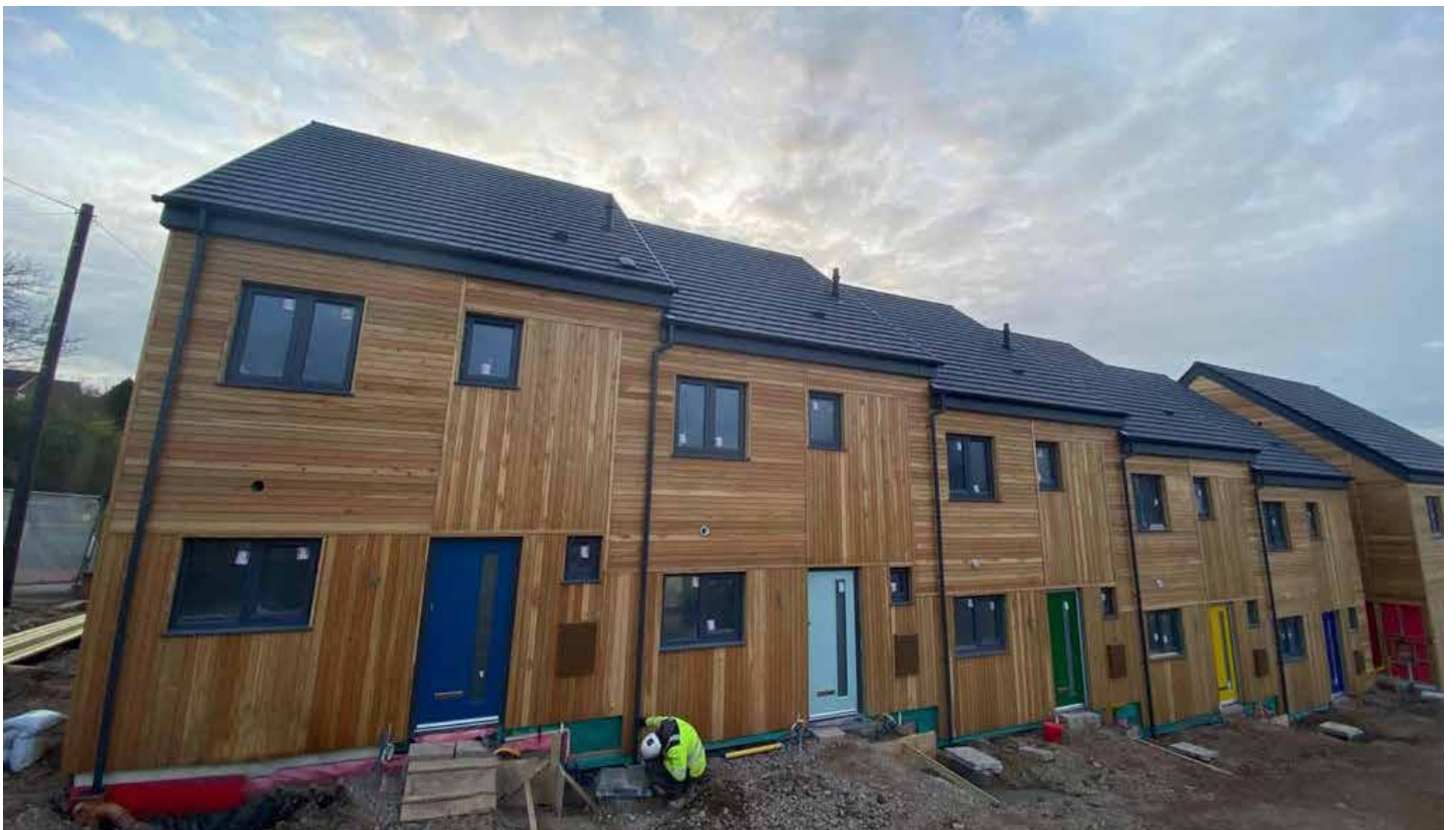
Complesso residenziale 5 ville a schiera a MALBOROUGH - (UK) - 2021
