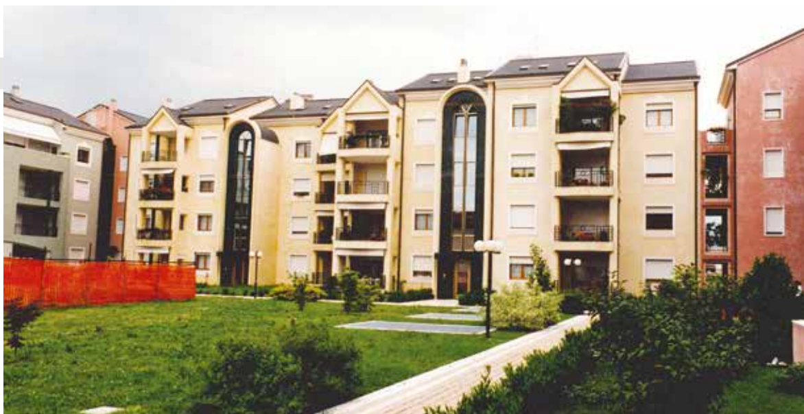
Intervento di 50 alloggi a TREVISO - 1993
