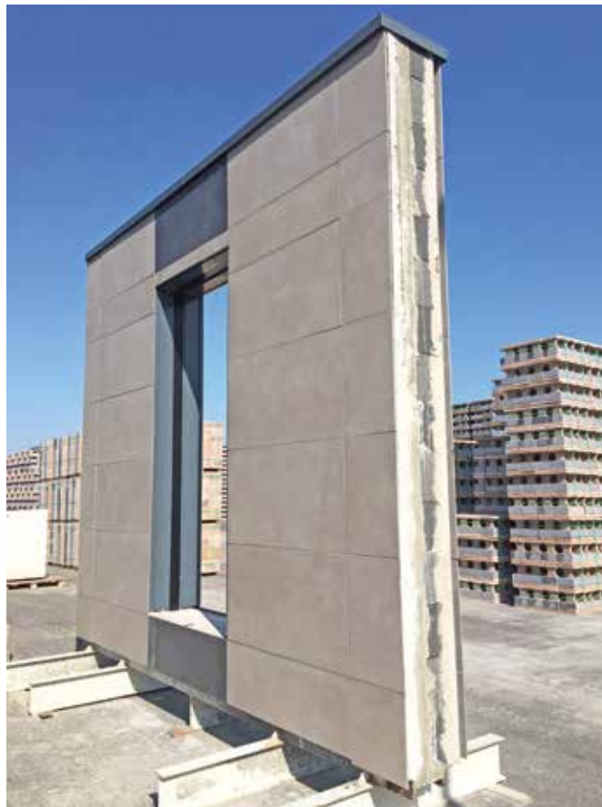
Lato esterno con rivestimento in ceramica e lato interno con parete ventilata
