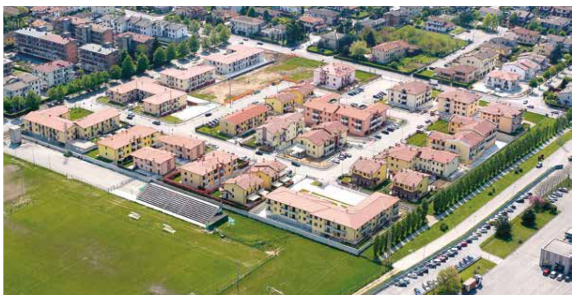
Quartiere residenziale di 120 alloggi a VICENZA - 2005
