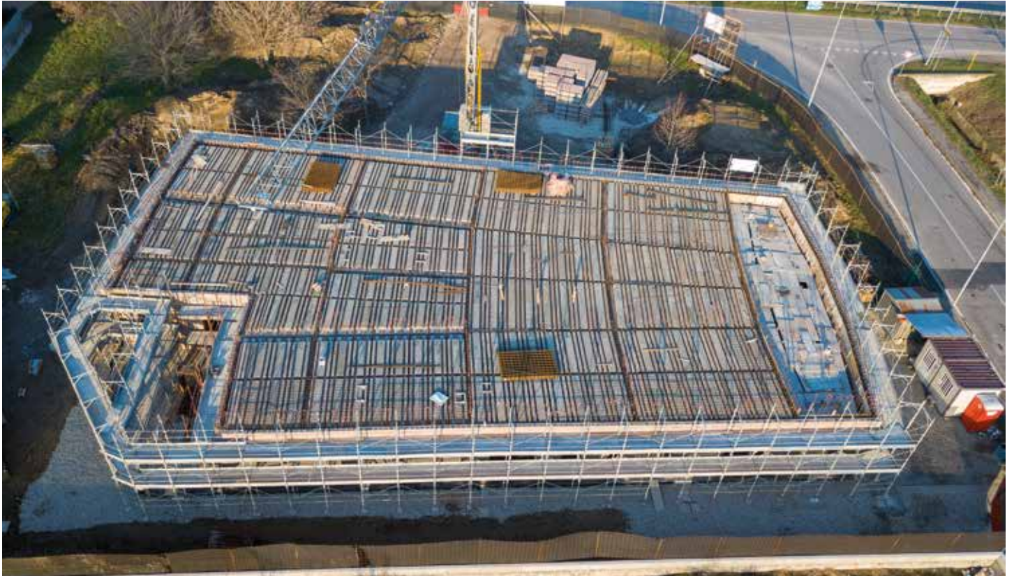
Clinica veterinaria con 800 mq. di solaio ISOTEX a CREMONA - 2018
