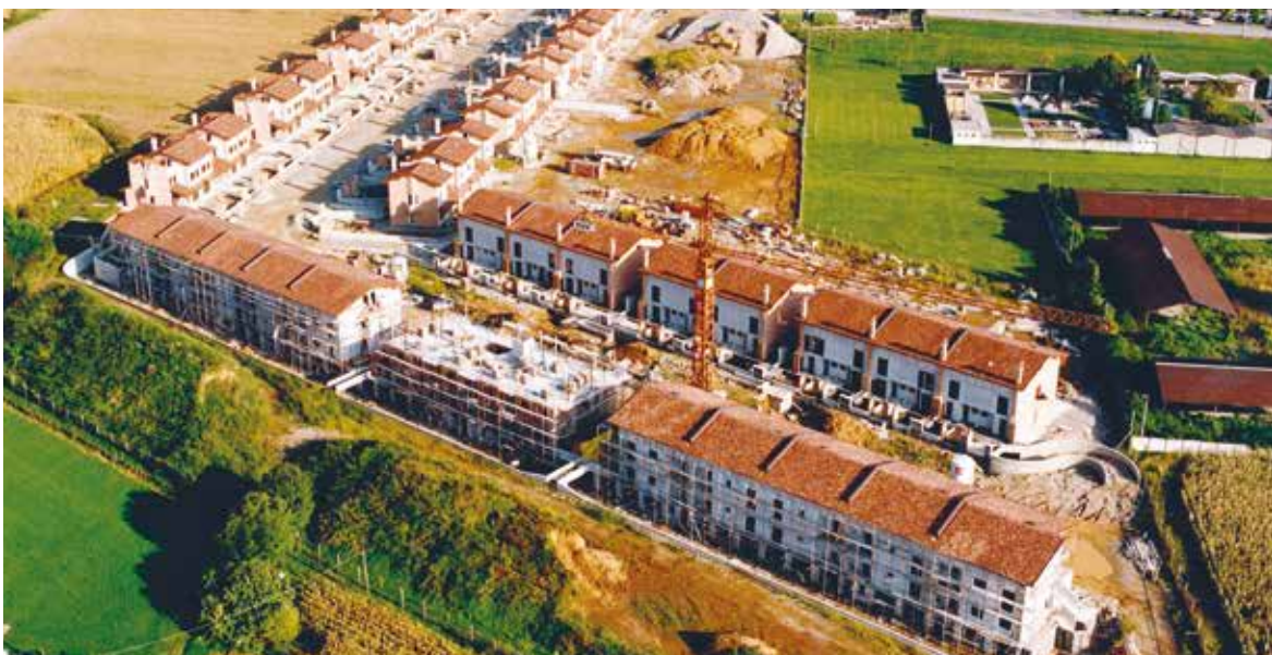
Intervento di 160 alloggi a BERGAMO - 1995
