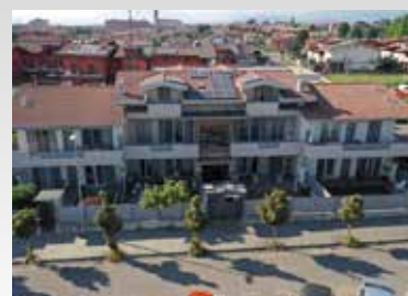
MCA di Carne di Bergamo dal 1988 ad oggi ha realizzato circa 250 abitazioni
