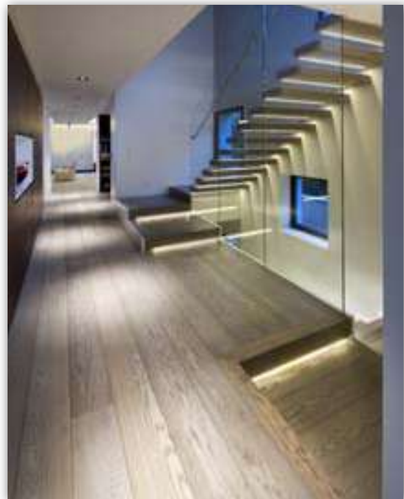
S20. Scale a giorno con gradini a sbalzo in legno, vetro e metallo fissati a parete
