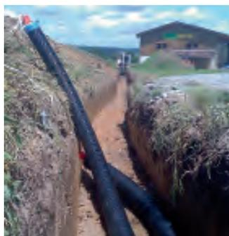
Le tubazioni Austroflex sono collocate direttamente nel terreno attraverso scavi contenuti. Questo è particolarmente utile quando il terreno scavato viene depositato in posizione adiacente al sito. Dal lato libero le operazioni da eseguire sono le seguenti:
