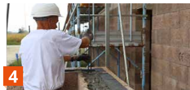
2 I corsi successivi si posano a secco
