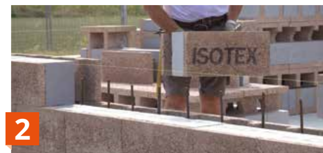
1 Posa del primo corso su malta, con bolla, per metterlo a livello
