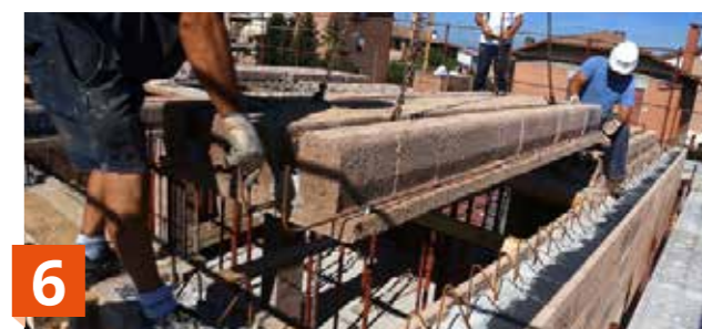
4 Inserimento delle armature verticali per antisismica a getto fresco
