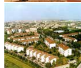
Quartiere Residenziale Fidenza (PR)
