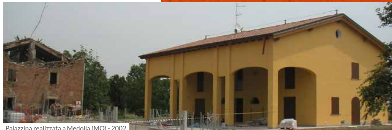
Palazzina realizzata a Medolla (MO) - 2002
