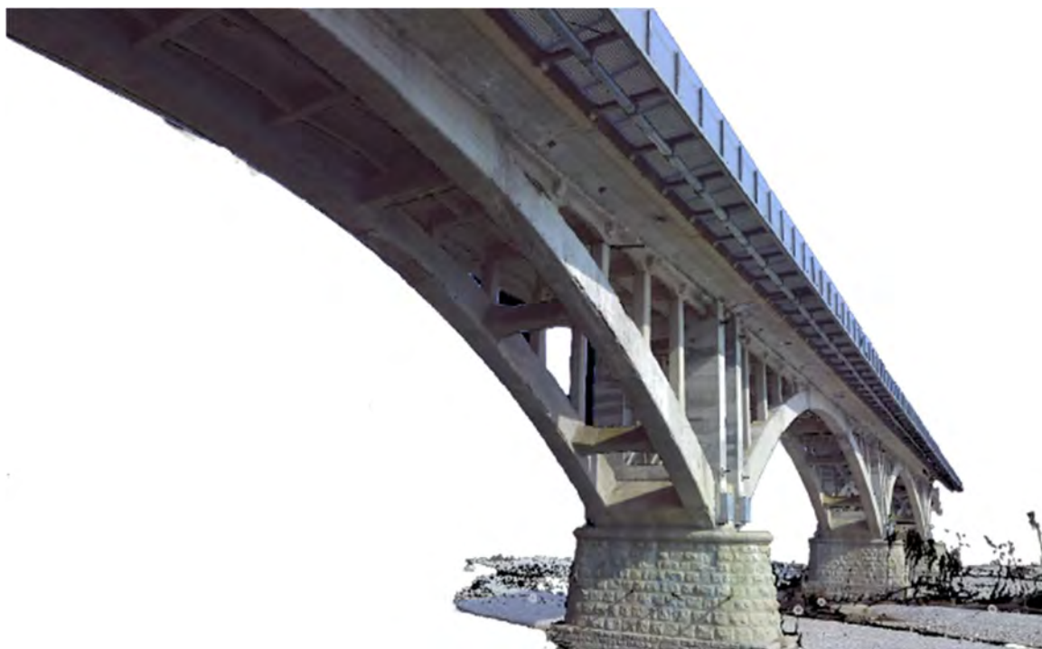
Immagine estratta da rilievo Laser Scanner su Ponte Stradale
